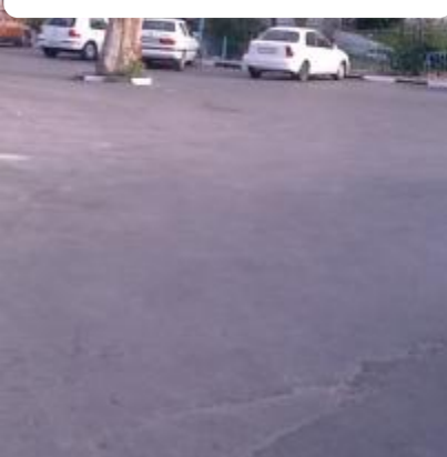
٣- التجمع المقابل لمبنى العيادات الخارجية
